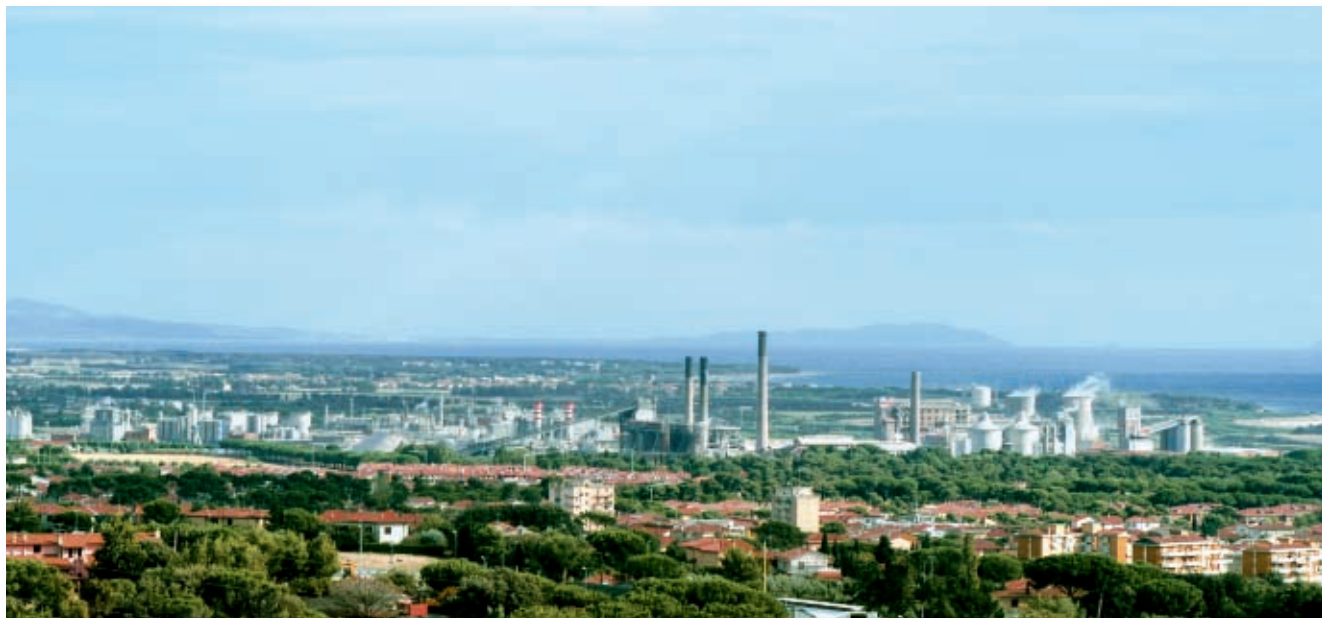
Rosignano - lo stabilimento
